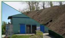
Usine de compostage des déchets ménagers
